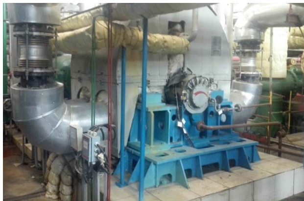
Турбопривод Р-3,15-2,8/1,3 П к питательному насосу ПН-500-180 Казанская ТЭЦ-3 2015 г.
