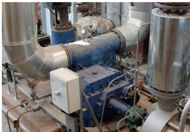
Турбопривод Р-1,6-1,0/0,13 П к питательному насосу ПН-270-150 Саровская ТЭЦ-1 2016 г.
