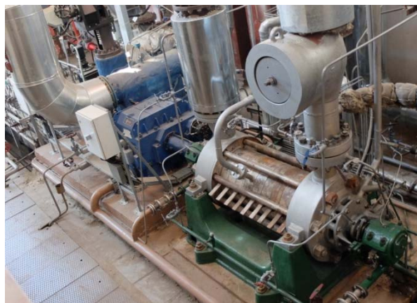
Турбопривод Р-1,6-1,0/0,13 П к питательному насосу ПН-270-150 Саровская ТЭЦ-1 2016 г.
