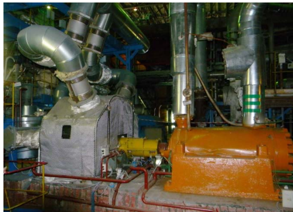
Турбопривод Р-3,7-1,8/0,75 П к питательному насосу ПН-580-185 Ново-Кемеровская ТЭЦ 2014 г.
