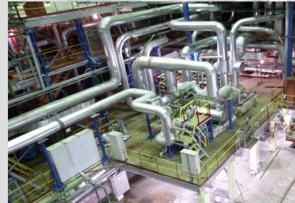
Турбопривод Р-3,7-1,4/0,17 П к питательному насосу ПН-580-185 Нижнекамская ТЭЦ-1 2013 г.
