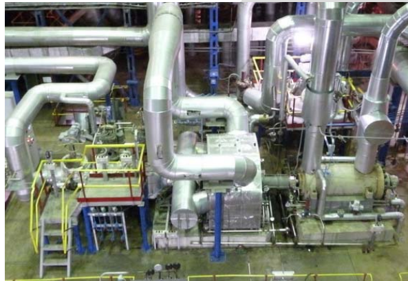
Турбопривод Р-3,7-1,4/0,17 П к питательному насосу ПН-580-185 Нижнекамская ТЭЦ-1 2013 г.
