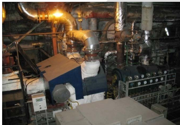
Турбопривод Р-2,6-0,85/0,15 П к питательному насосу ПН-380-185 Черниговская ТЭЦ 2011 г.
